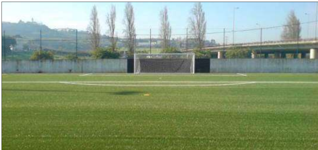
Após a intervenção
