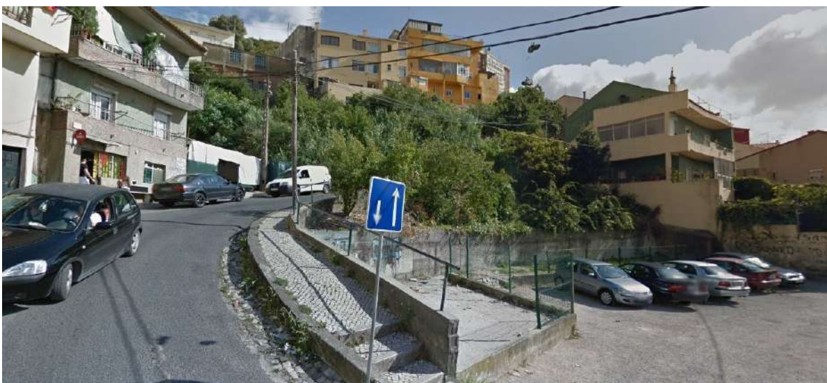
(aspeto do local anterior á intervenção)
