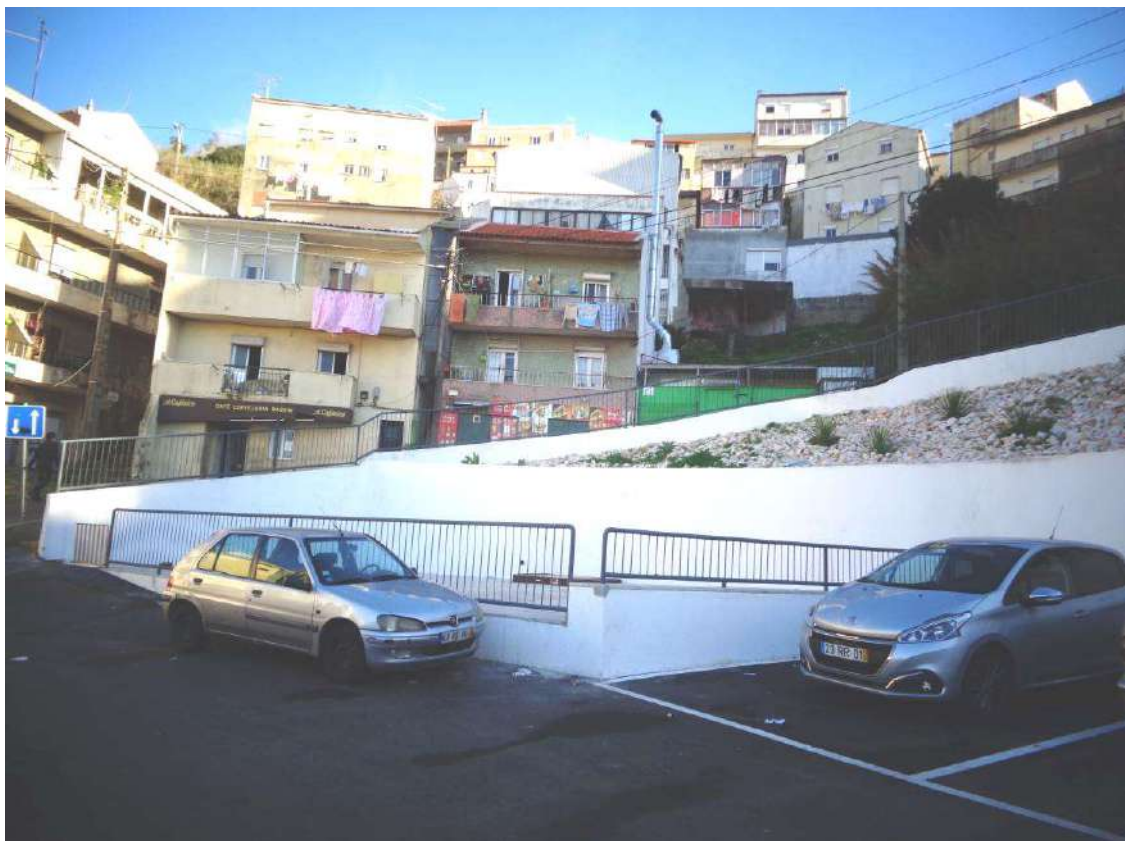
(aspeto do local posterior á intervenção)
