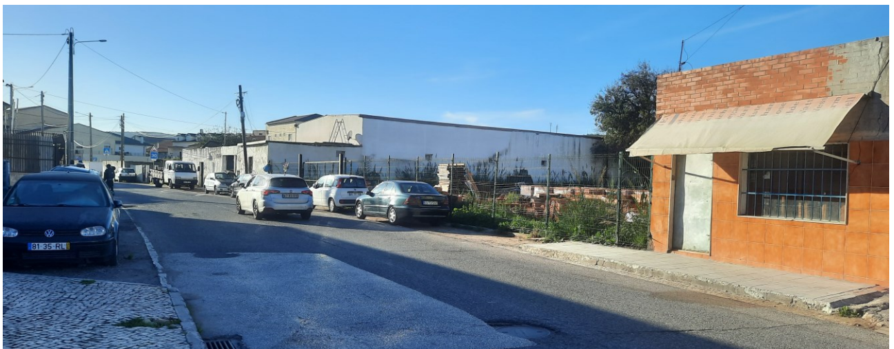
Estado geral antes da intervenção - nascente/poente
