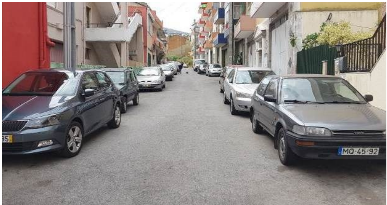
Estado geral antes da intervenção - poente/nascente
