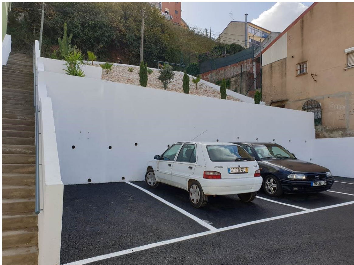
(aspeto do local posterior à intervenção - vista Norte /Sul)
