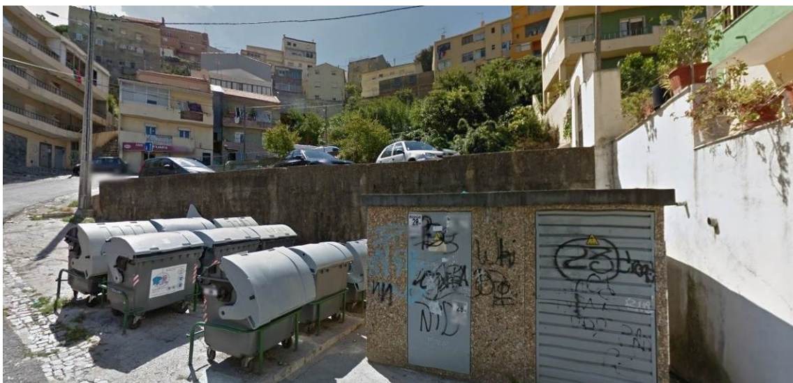
Aspeto do local antes das intervenções
