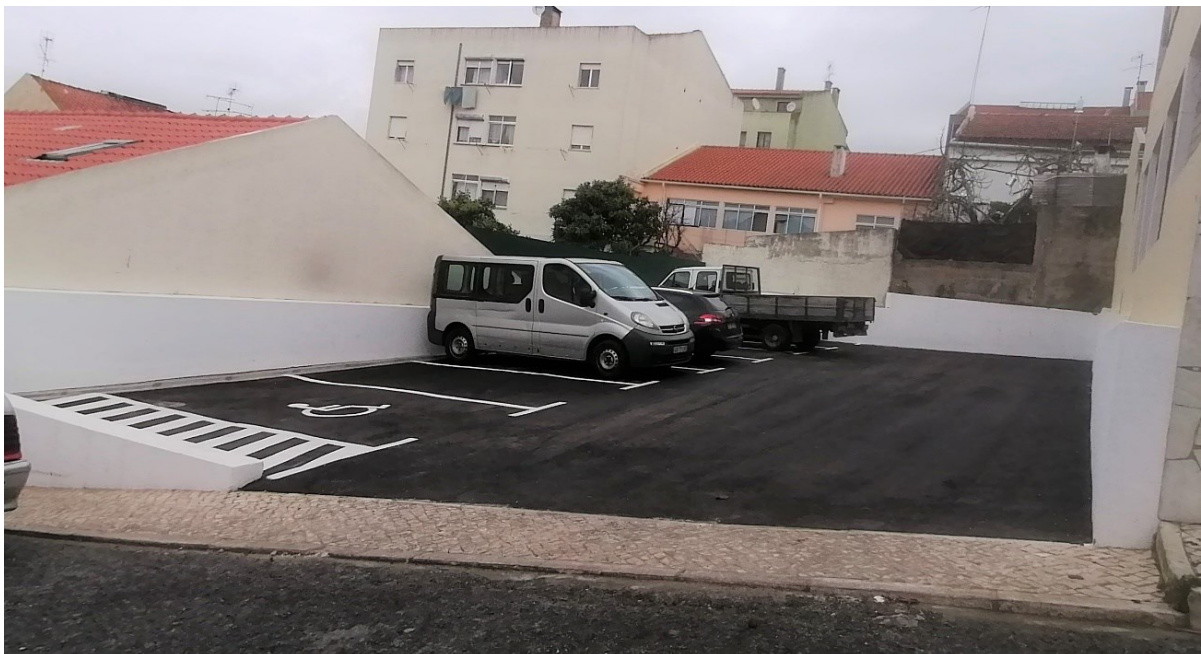
Local após a intervenção
