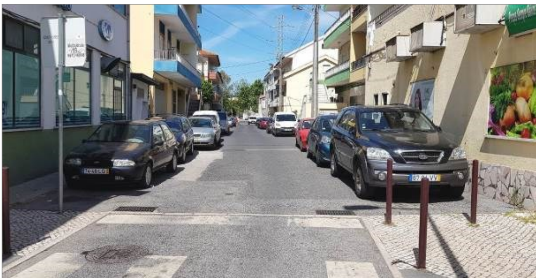
Estado geral antes da intervenção - poente/nascente
