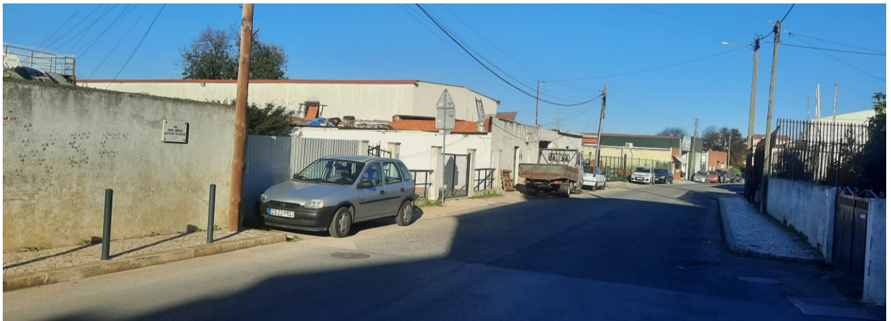
Estado geral antes da intervenção - poente/nascente
