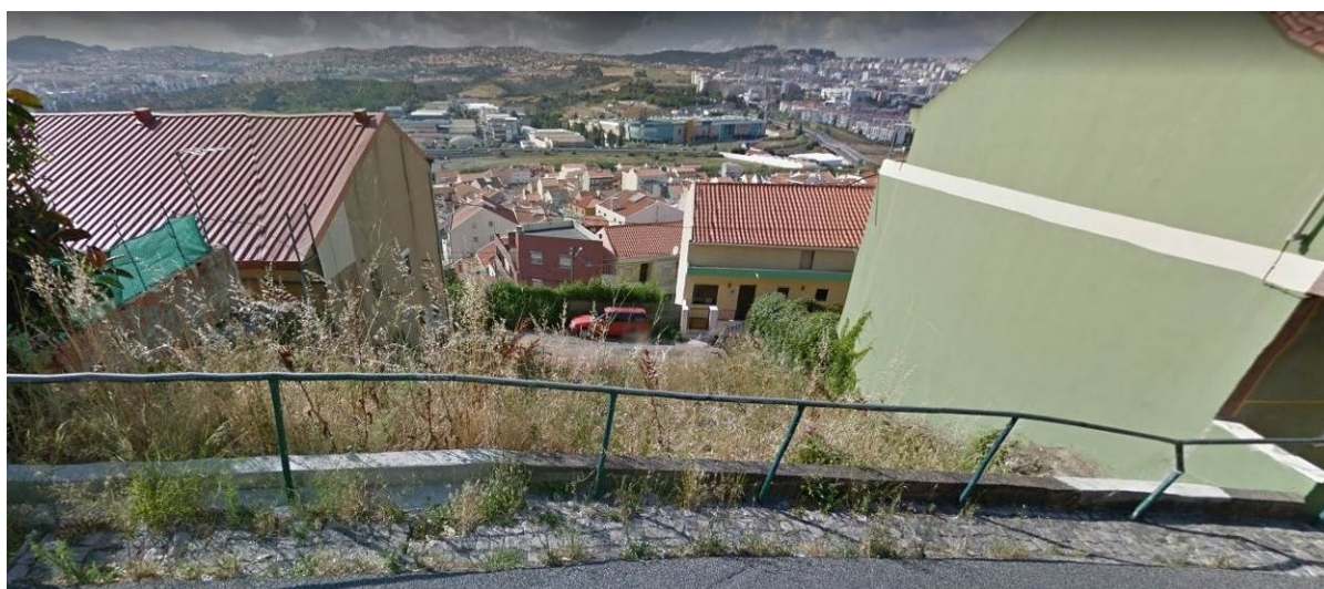
(aspeto do local anterior à intervenção - Vista Sul/Norte)
