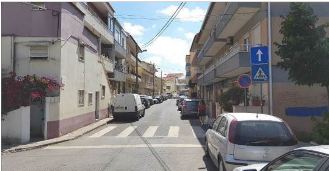
Estado geral antes da intervenção - nascente/poente
