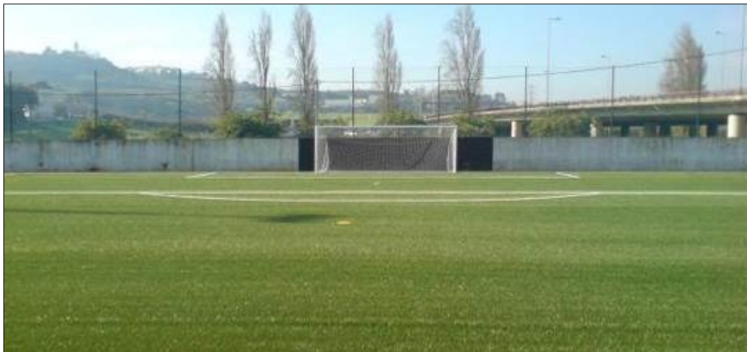
Após a intervenção
