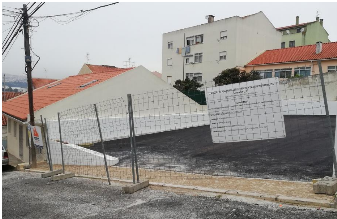
Local durante a intervenção
