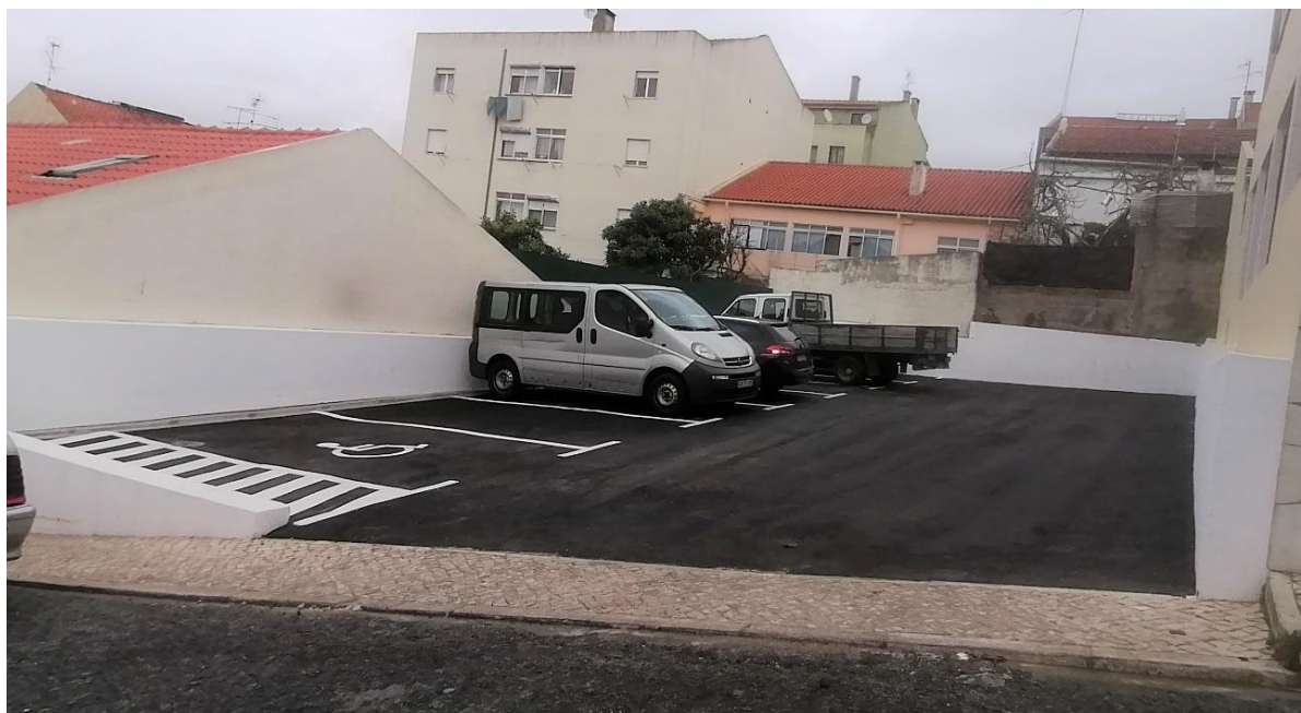
Local após a intervenção
