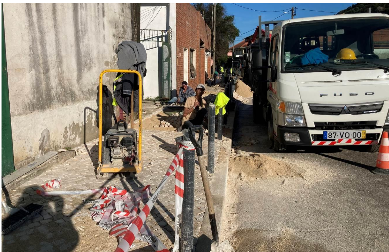
Estado geral durante a intervenção - poente/nascente
