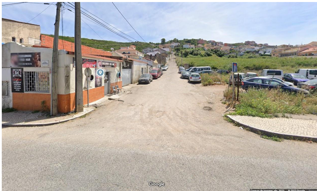
Estado geral antes da intervenção
