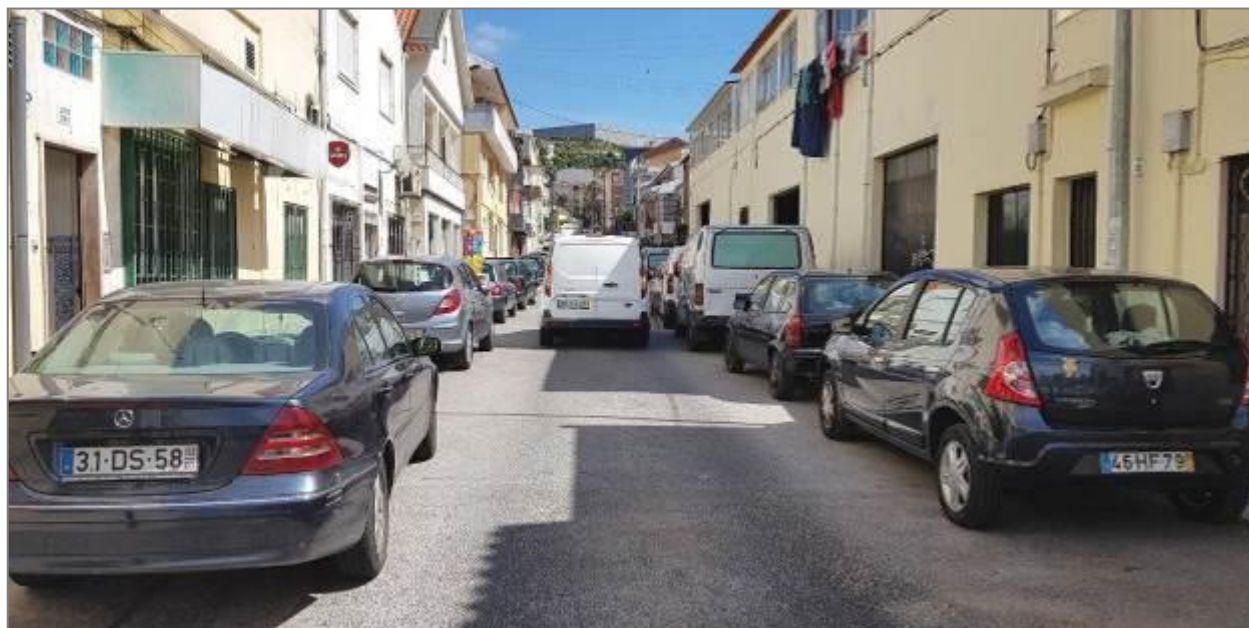
Estado geral antes da intervenção - norte/sul
