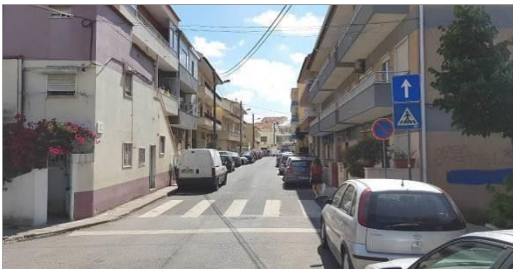
Estado geral antes da intervenção - nascente/poente
