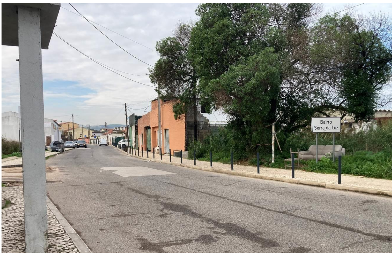
Estado geral após intervenção - nascente/poente
