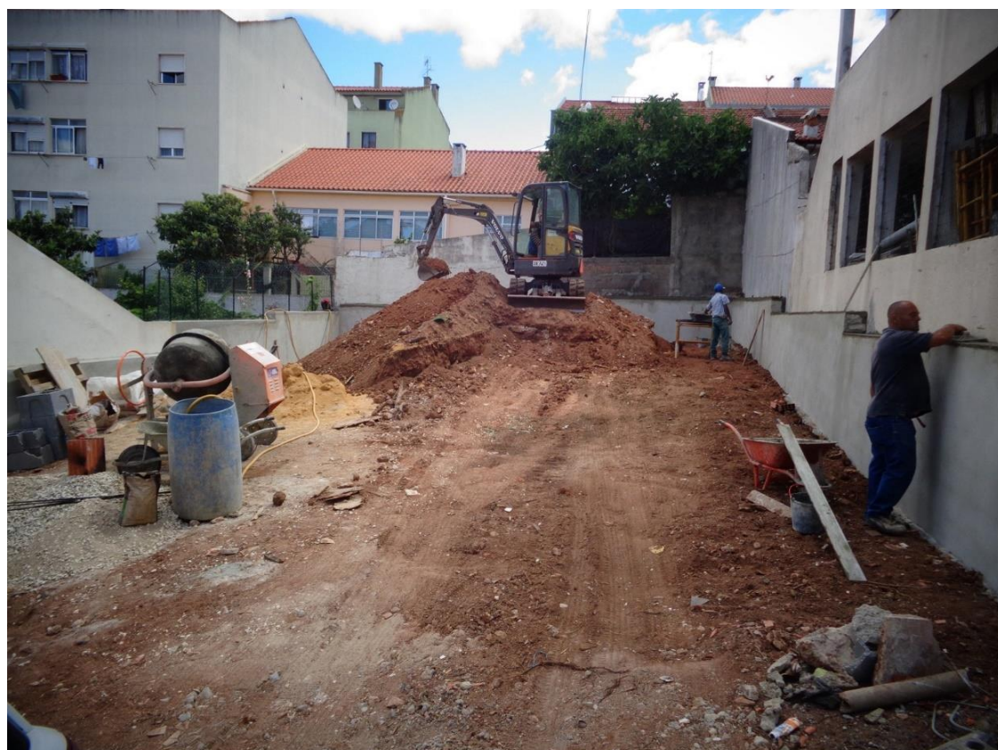
Local durante a intervenção
