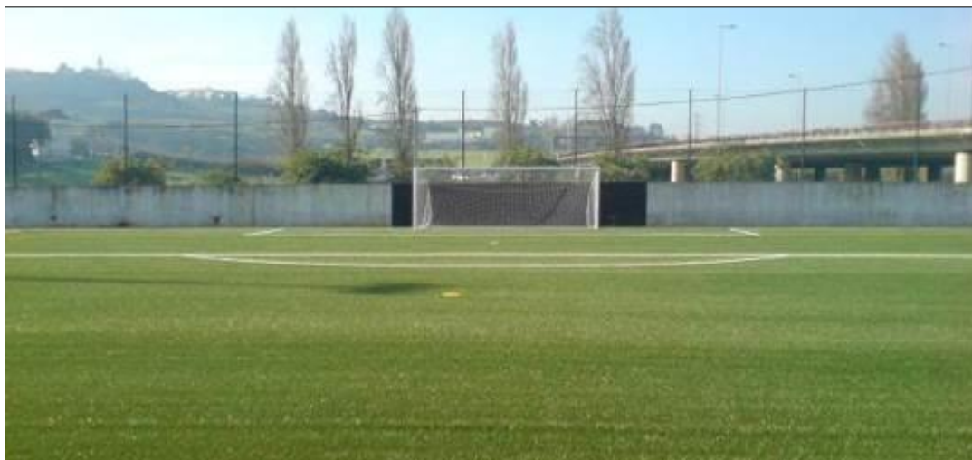
Após a intervenção
