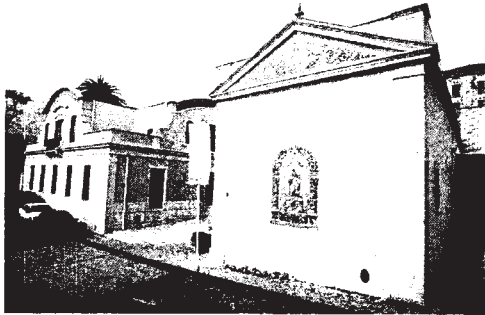
Fig. 1 – Fachada da BMDD
