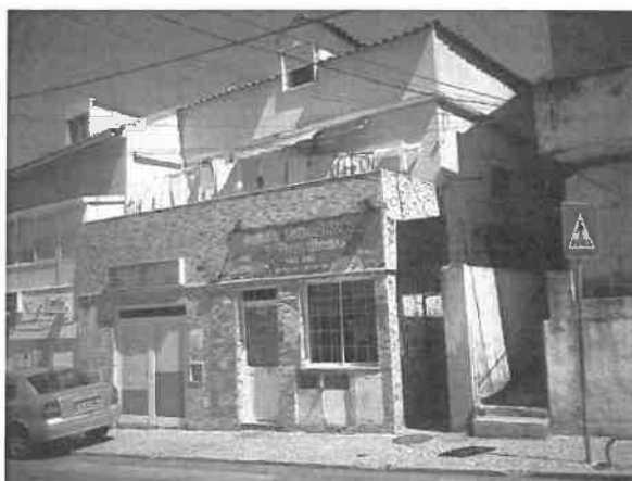
Fotografia 1 – Perspetiva e estado atual da construção onde se localiza a pretensão.
