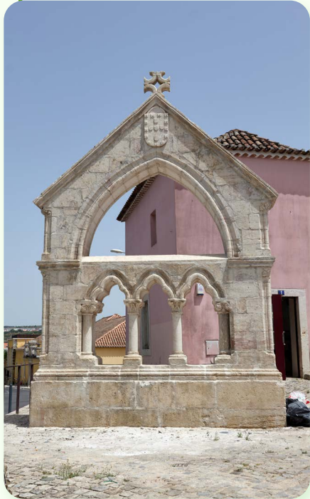
Conclusão das obras de conservação e restauro do Memorial de Odivelas .
