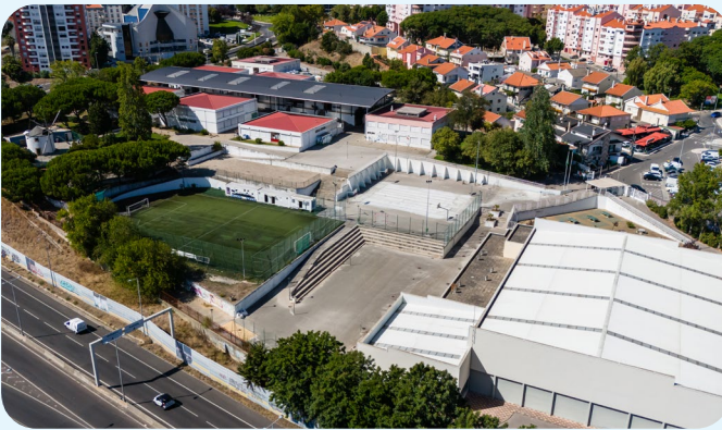
Requalificação da Escola Secundária da Ramada
