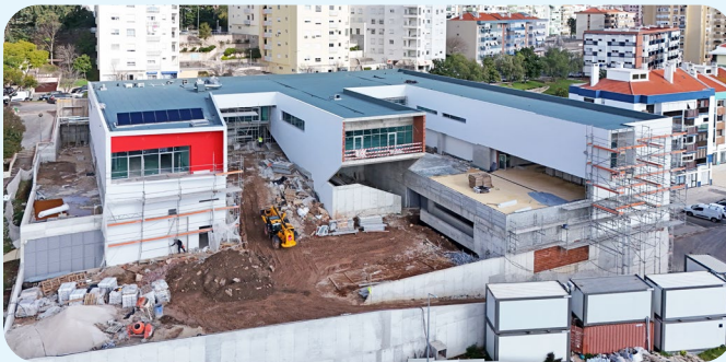
Construção da EB N.1 da Amoreira
