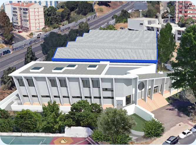
Requalificação do Pavilhão Municipal Honório Francisco
