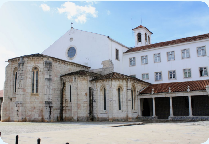
Beneficiação do Mosteiro de Odivelas
