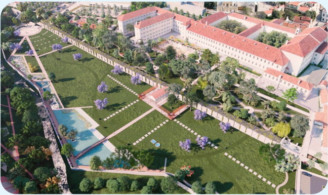
Construção do Parque da Cidade
