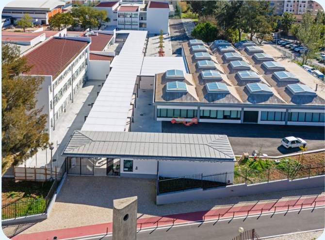
Requalificação da Escola Secundária de Odivelas
