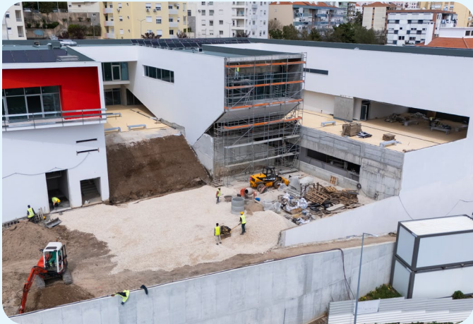
Construção da EB N.º1 da Amoreira
