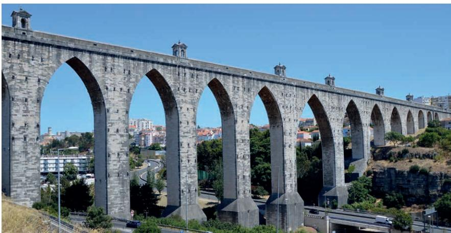
**FIG. 8** O Aqueduto das Águas Livres, em Lisboa, tem 65 m de altura e 941 m de comprimento, na sua travessia sobre o vale de Alcântara. Foi construído para reforçar o abastecimento de água à cidade de Lisboa e resistiu ao terramoto de 1755.
