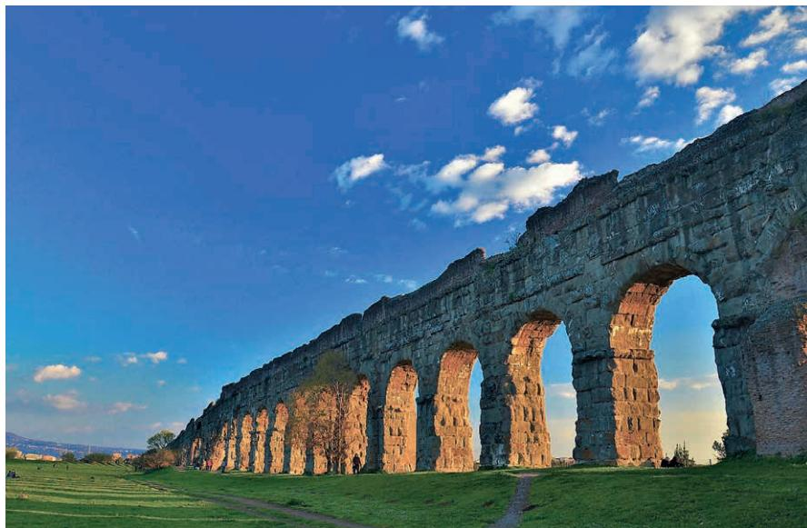
**FIG. 1** Aqueduto Aqua Claudia, com 69 km de extensão, construído nos finais do século I a.C. Obra exemplar da engenharia hidráulica romana, é considerado o maior aqueduto, em termos de capacidade de água transportada diariamente, da antiga cidade de Roma.
