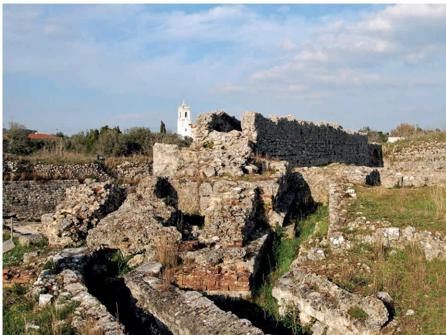
**FIG. 2** Vestígios do Castellum Divisorium (conjunto de ruínas de Conimbriga). A partir deste reservatório, a água, transportada pelo aqueduto, era distribuída para diferentes bairros da cidade, termas e fontes.
